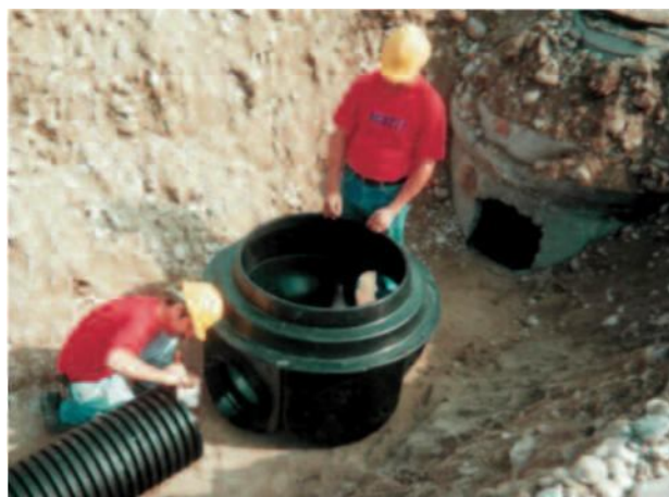
Рисунок 20. Соединение лотка ПЭ колодца с трубой
