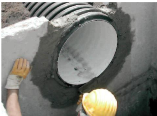
Рисунок 19. Монтаж трубы в бетонном колодце
